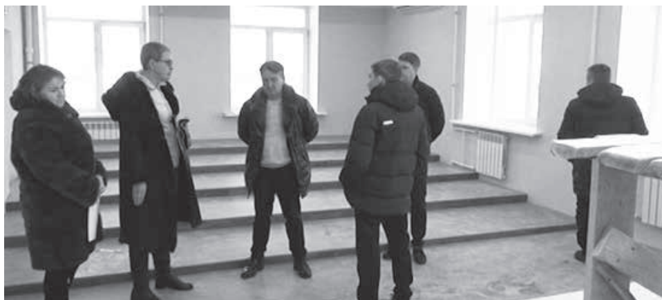
Капитальный ремонт подходит к завершению
